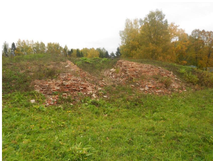
Фундамент разрушенной церкви.
